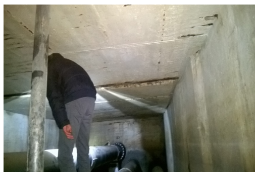
Zdj. 1 - Strop – powierzchnia, w stosunkowo dobrym stanie. Odkryte na znacznej powierzchni pręty zbrojeniowe
