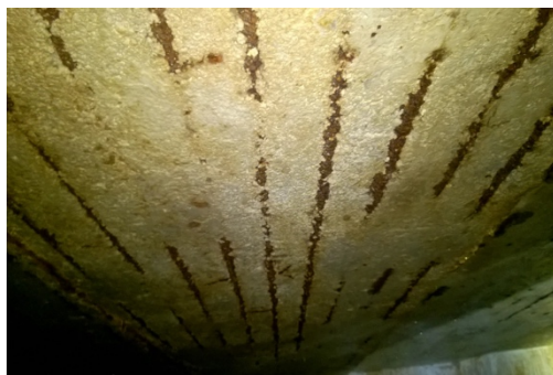
Zdj. 1 - Strop – powierzchnia, w stosunkowo dobrym stanie. Odkryte na znacznej powierzchni pręty zbrojeniowe
