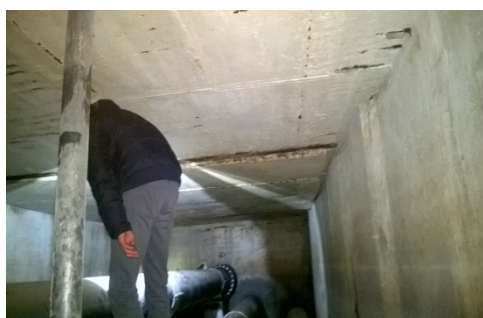
Zdj. 6 – ściany boczne, stalowe elementy będące źródłem zacieków wymagające usunięcia
